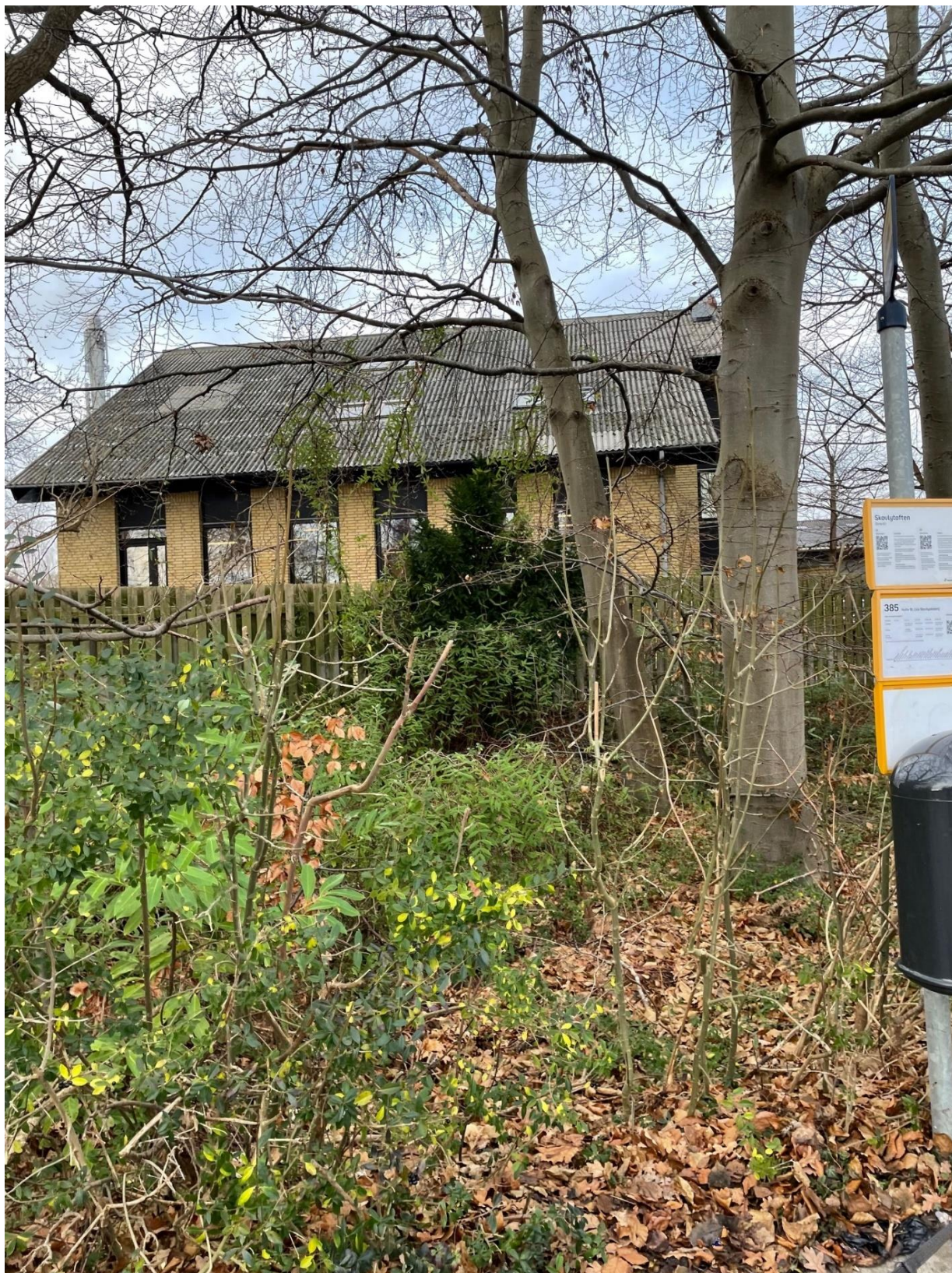
Figur 1. Dokumentation af mangelfuld beplantning mellem Borgmester Schneiders Vej og ejendommen beliggende Skovlytoften 1 (foto taget d. 23. december 2025 ved busstoppestedet over for Borgmester Schneiders 12 og 14)
