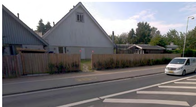
Påbud udstedt 12.11.2021. Hegnet er trukket tilbage og beplantning er på vej.
